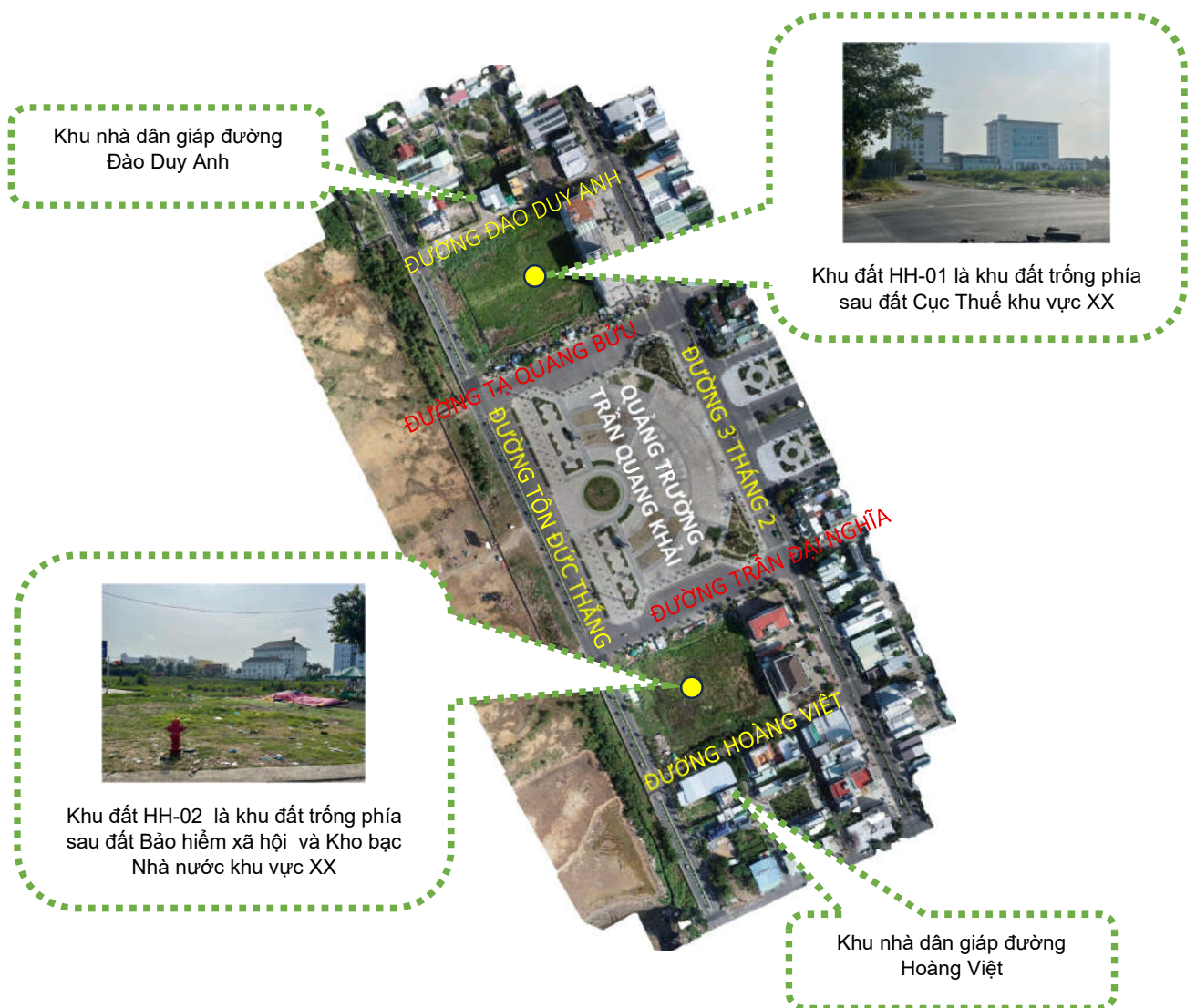
Ảnh chụp hiện trạng hai khu HH-01 và HH-02 từ flycam
